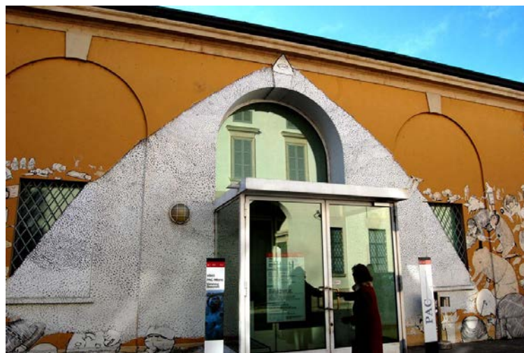
Figuras 37, 38 y 39. Paredes del PAC de Milán pintadas por Blu (2007). Fotografías realizadas por el autor.
